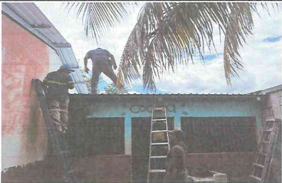
Foto 3. Finalización cambio de estructura y lamina de cocina.
