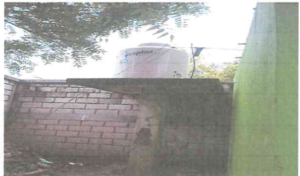
Foto 4. Finalización Cambio de rotoplas.
