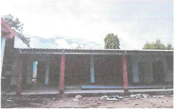
Foto 1: Finalización Cambio de estructura y lámina de dos aulas
