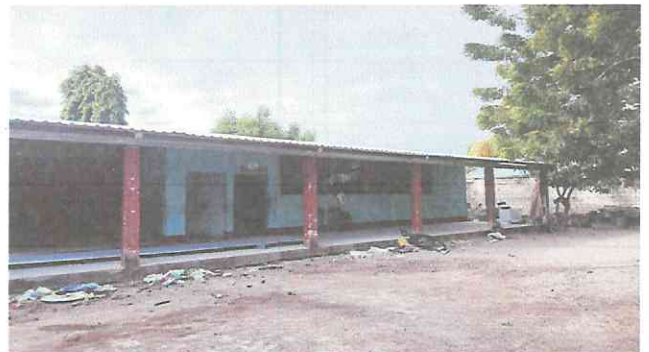
Foto 2: Finalización Cambio de estructura y lámina de dos aulas
